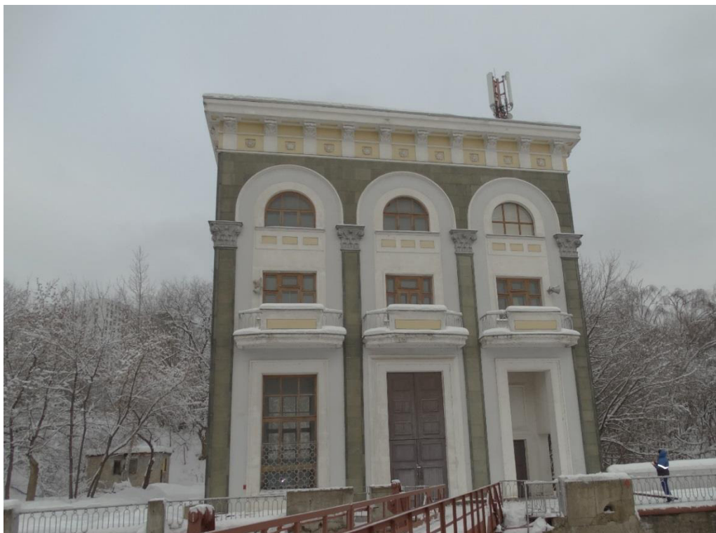
Рисунок Д.41. Общий вид башни управления нижней головы левого устоя
