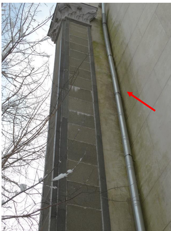
Рисунок Д.48. Протечки по стене S=24,0 \text{ м}^2
