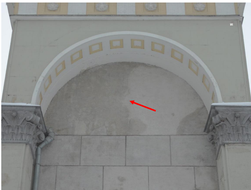
Рисунок Д.36. Протечки по стене S=10,0 \text{ м}^2
