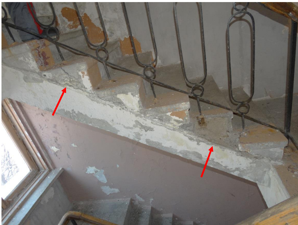
Рисунок Д.21. Сколы ступеней в местах заделки перил глубиной 7,0 см. Пластовая коррозия стоек перил. Толщина продуктов коррозии \Delta=2,0 см
