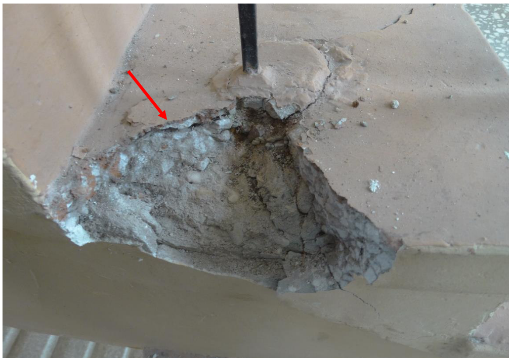
Рисунок Д.1. Сколы ступеней и лестничных площадок в местах заделки перил глубиной 7,0 см
