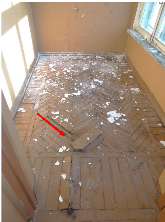
Рисунок Д.16. Износ напольного покрытия из паркета
