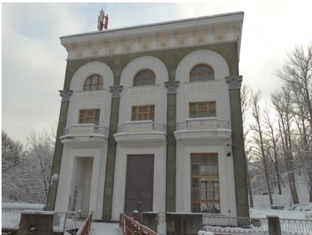
Рисунок Д.46. Общий вид башни управления нижней головы правого устоя
