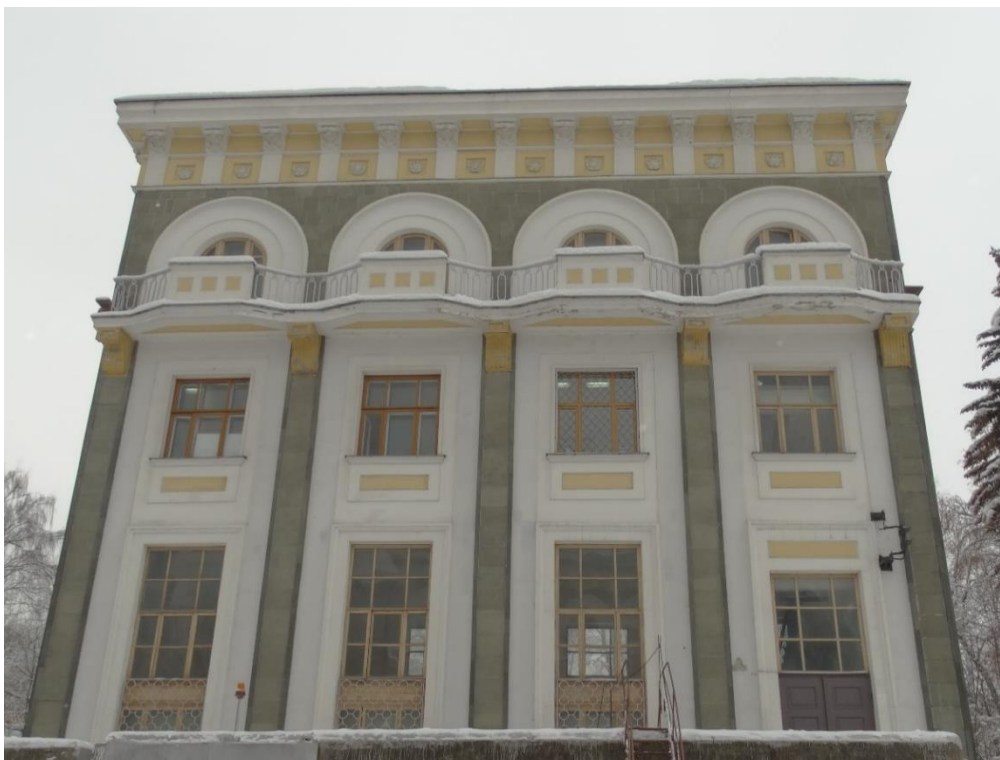
Рисунок Д.33. Общий вид башни управления верхней головы правого устоя
